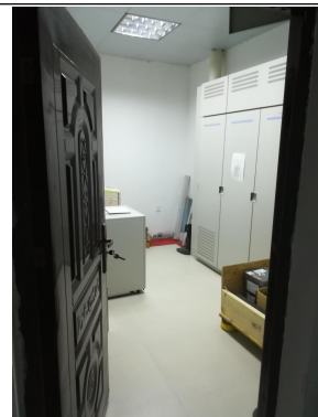
照片 8-8 拟建 DSA 机房西侧设备室
